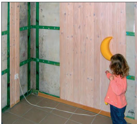
Schimmelpilzbewuchs kann sich auch in nicht einsehbaren Bereichen bilden – im vorliegenden Fall entwickelte sich der Schimmel hinter einer vorgeblendeten Holzverschalung, hinter der sich die Feuchtigkeit niederschlug. Die Sporen des Pilzes gelangen von dort in die Innenraumluft. Sie sind neben Hausstaubmilben die wichtigsten Allergene und können zu schweren gesundheitlichen Beeinträchtigungen bis hin zu chronischem Asthma führen.
