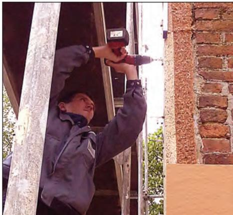
UdiRECO Dämmplatten passen sich dem Untergrund winddicht an älteren Gebäuden, die energetisch aufgewertet werden müssen. Um diesen Bestand möglichst nachhaltig und dauerhaft wertbeständig zu sanieren, ohne die Bausubstanz auf lange Zeit zu schädigen, bietet Unger-Diffutherm ein interessantes Dämmsystem an, das aus nachwachsenden Holzfasern hergestellt wird. Mit
