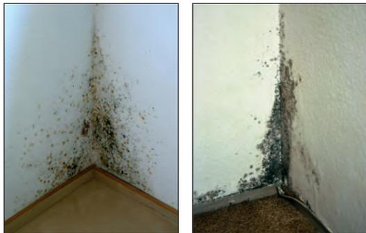
Typische, durch Wohnfeuchte verursachte Schimmelschäden. Die relative Luftfeuchtigkeit ist an kühlen Bauteiloberflächen höher als in der Raumluft. Der feuchte Untergrund bildet einen idealen Nährboden für Schimmelpilze.
