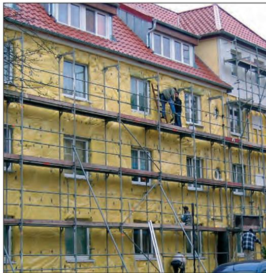
Eine gute Wärmedämmung reduziert nicht nur Wärmeverluste, sondern auch Wärmebrücken
